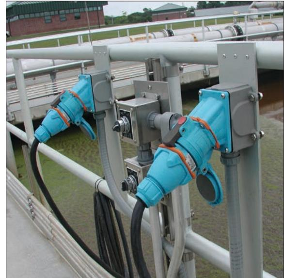
*Instalar un tomacorriente Certificado como Seccionador MELTRIC entre una caja de conexiones para motor y la línea de suministro de energía elimina todas las tareas de alambrado durante el intercambio de motores. La desconexión de la carga se lleva a cabo en segundos al presionar el botón rojo en el gatillo, en el envolvente del tomacorriente*
