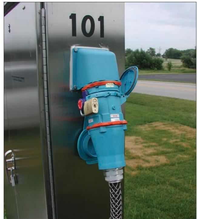
*Los dispositivos Meltric Certificados como Seccionador pueden ser bloqueados y etiquetados en la posición Conectado - "On" o Desconectado - "Off", para eliminar la posibilidad de contacto con partes energizadas, lo que no es posible con equipos de "punta y manga".*
