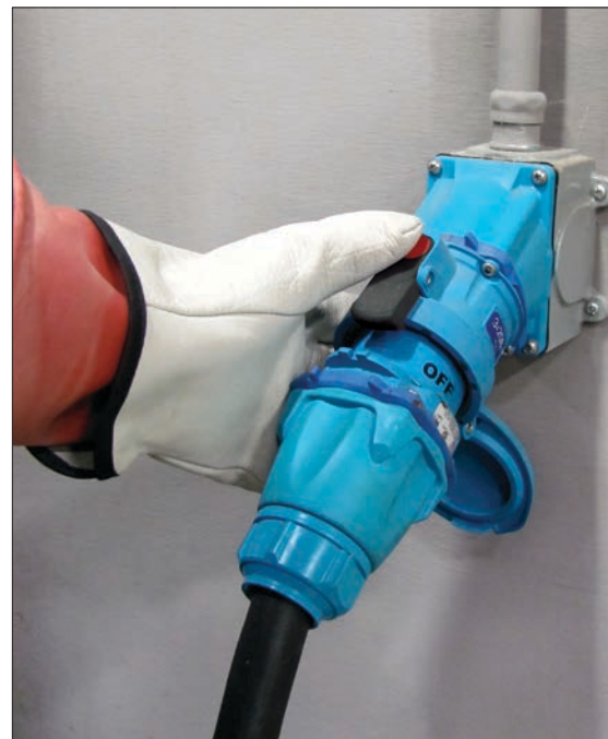
Los tomacorrientes Certificados como Seccionador MELTRIC cumplen con los requerimientos del NEC como seccionadores en “línea de vista”. Presionando el botón rojo en el gatillo del tomacorriente se desconecta el circuito y garantiza la remoción segura de la clavija del tomacorriente.
