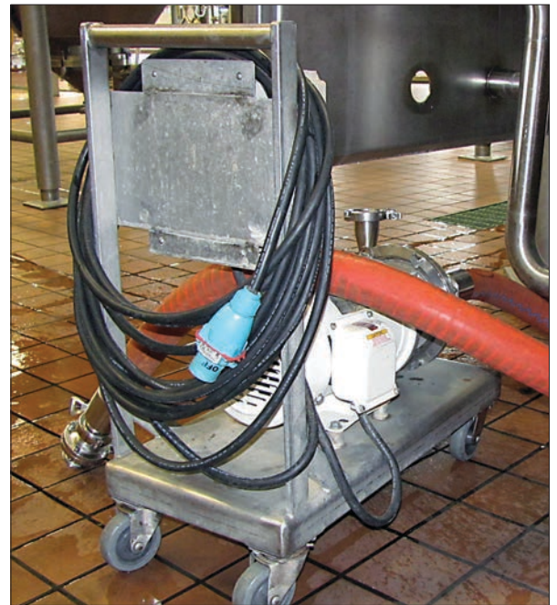
En la Cervecería Bell, las bombas móviles son conectadas con tomacorrientes Certificados como Seccionador MELTRIC. Los contactos de plata-níquel proporcionan conexiones confiables, sin corrosión, incluso en condiciones agresivas.
