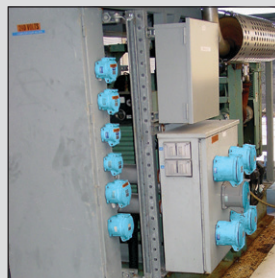
Los tomacorrientes y clavijas MELTRIC garantizan la protección contra arco eléctrico y simplifican el cumplimiento de la NFPA 70E.
