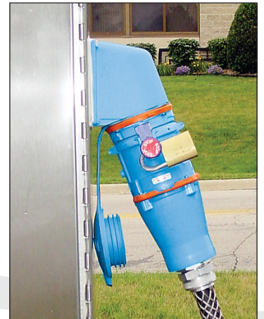
Durante el desarrollo de la prueba la clavija es bloqueada estando conectada, para evitar lesiones a personas no autorizadas que pudieran tratar de removerla.
