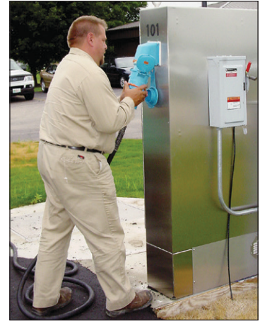
Conectando un generador de 100 A en un generador de conexión remota en Watertown, WI.
